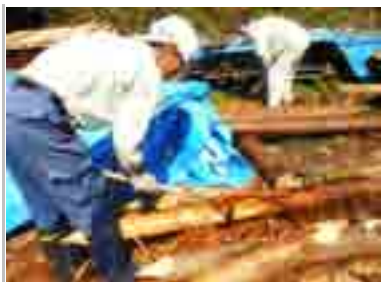
土留めの杭、皮剥ぎ作業
