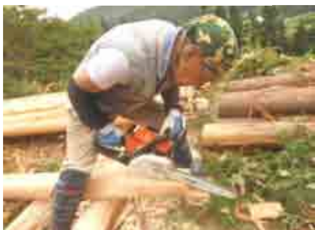
柱・梁の小屋の材料をチェーンソーで刻む
