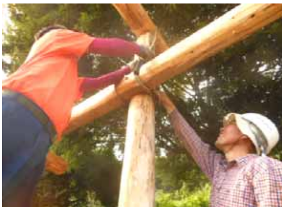
梁を組み込んだ柱は重くて大変、ウインチ、滑車、ロープ、ハシゴを駆使して立ち上げる
