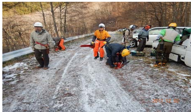
○ 急斜面の作業でした！
