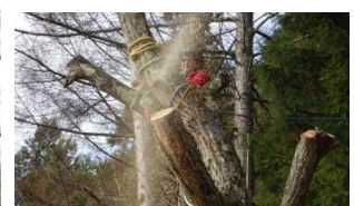
木に登って枝にロープをかけて切り、ポーターラップを使用して安全に下ろします
