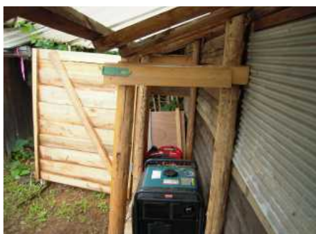
軒下を有効活用した発電機室が完成！
